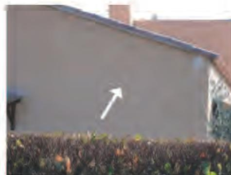
Fissuration traduisant un décollement de la structure par absence de liaisolement entre niveau bas et combles.
